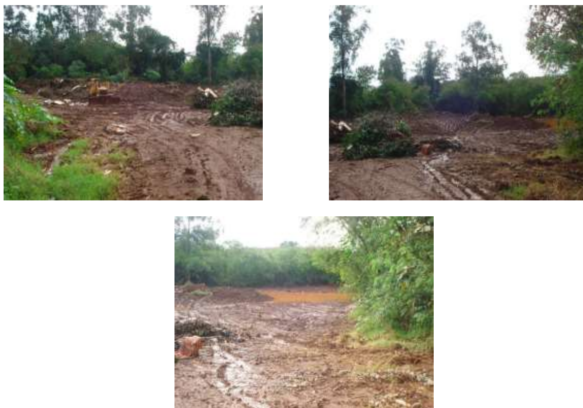
Figura 103 - Disposição de resíduos de poda, construção civil, entulhos.
