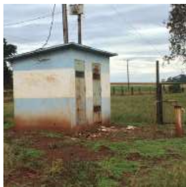
Figura 48 - Poço 11. Fonte: CEPMSB, 2015.
