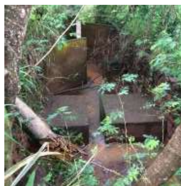
Estrutura dissipadora de energia
