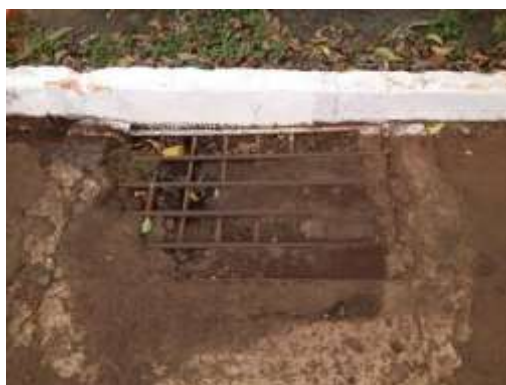
Figura 73 - Microdrenagem assoreada, sem manutenção.
