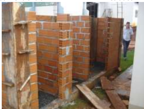
Armazenamento temporário de resíduos de serviços de saúde e convencionais (em construção)
