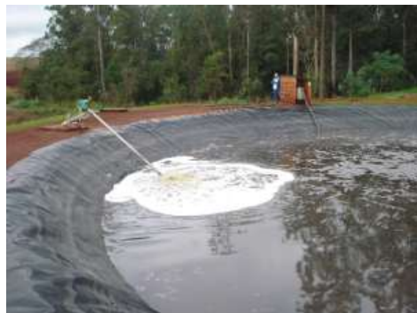
Lagoa de Aeração
