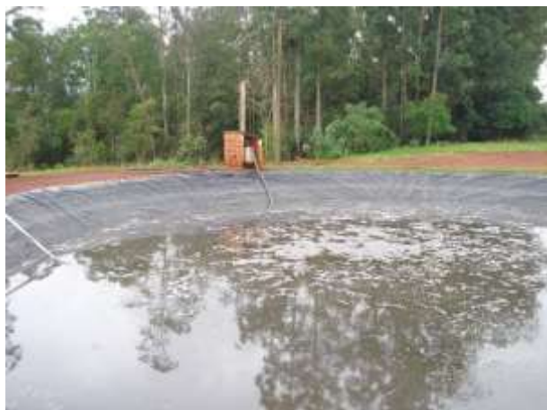
Efluente do Biodigestor
