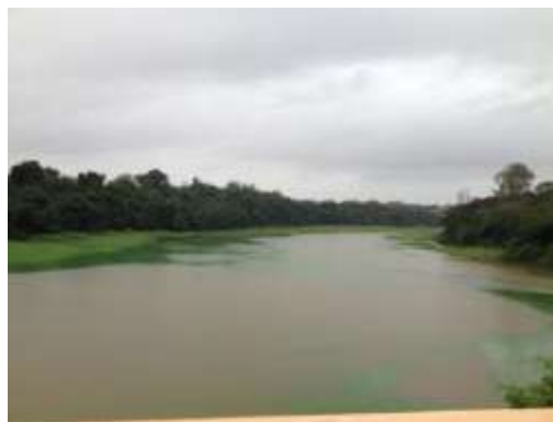
Ponte da PR-495 (Lago Itaipu)
