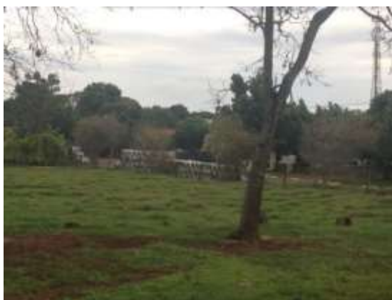
Figura 86 - Manilhas de concreto no local das obras de microdrenagem – Avenida Suburbana.
