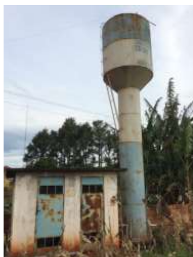
Figura 56 - Poço 16 e Reservatório.
