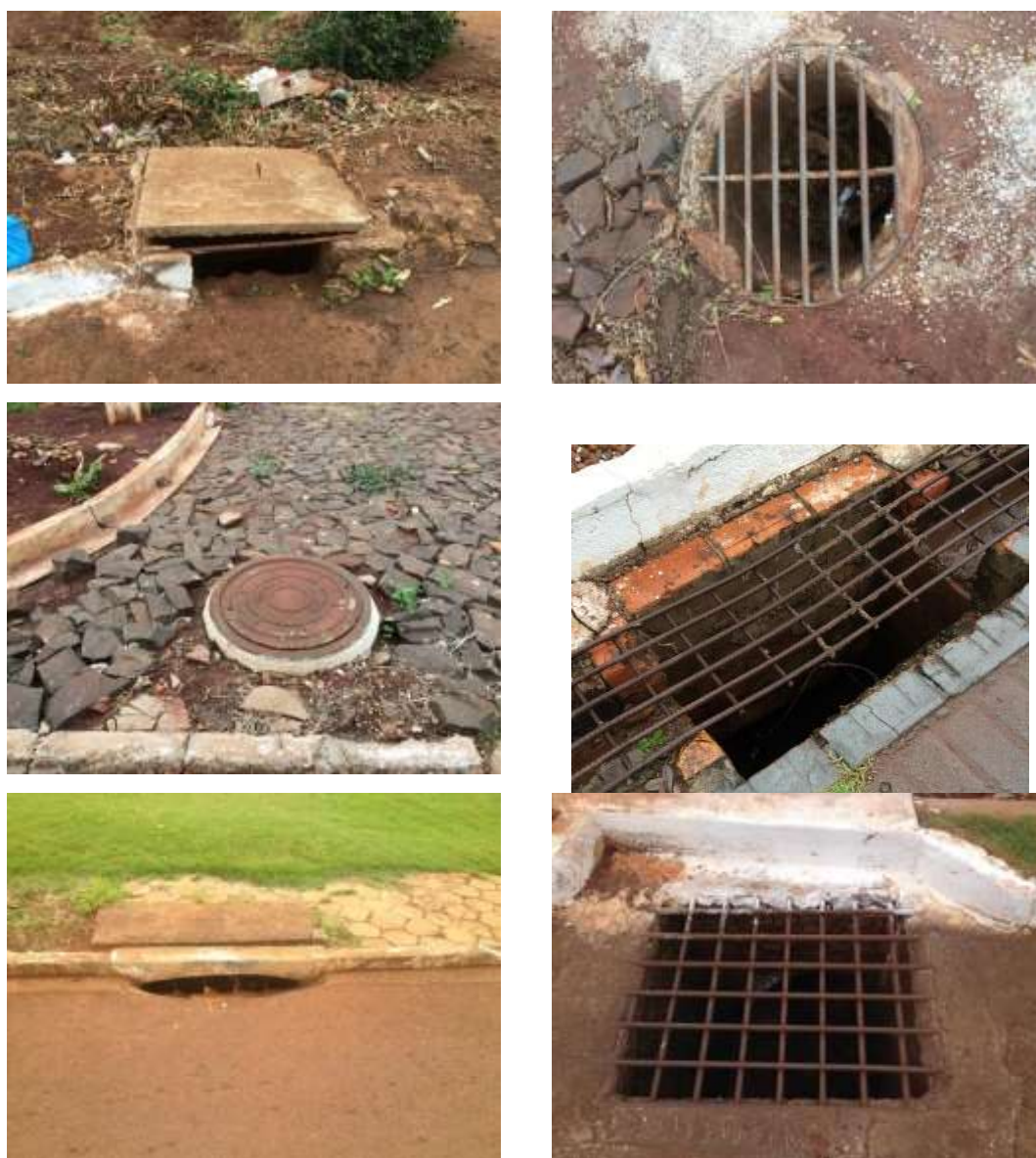
Figura 74 - Diferentes tipologias de bocas de lobo encontradas no município de Entre Rios do Oeste.
