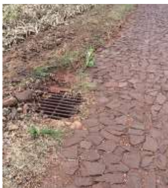
Via com pedra irregular nas Linhas
