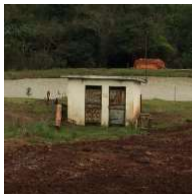
Figura 44 - Poço 26. Fonte: CEPMSB, 2015.
