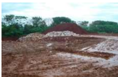
Aterro Controlado (valas)
