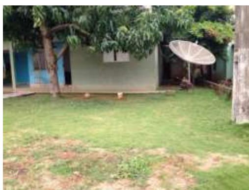
Fossa Séptica na frente na residência
