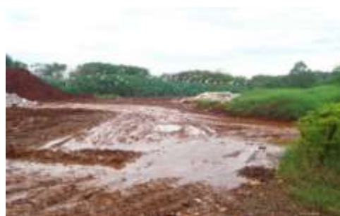
Aterro Controlado (valas)
