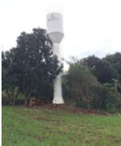
Figura 59 - Reservatório poço 29. Fonte: CEPMSB, 2015.
