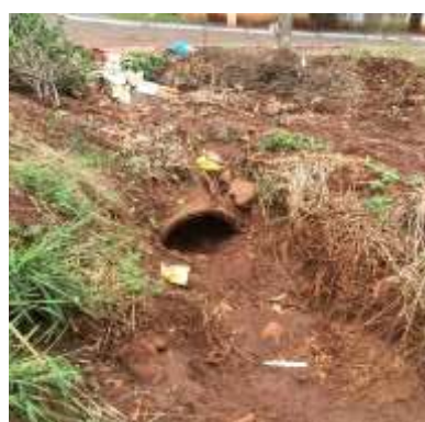
Figura 73 - Microdrenagem assoreada, sem manutenção.
