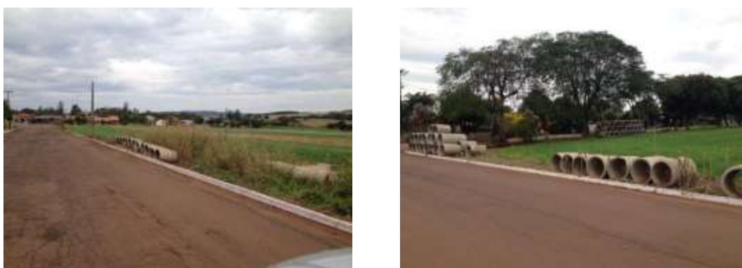
Figura 85 - Manilhas de concreto no local das obras de microdrenagem – Sanga Tucano.
