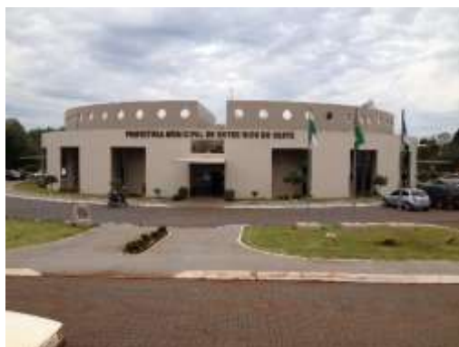
Prédio da Prefeitura e da Sec. de Viação e Obras
