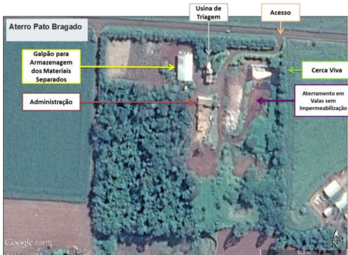
Figura 97 - Aterro Controlado de Pato Bragado
